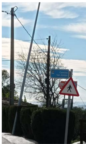
Estado de uno de los acerados.
